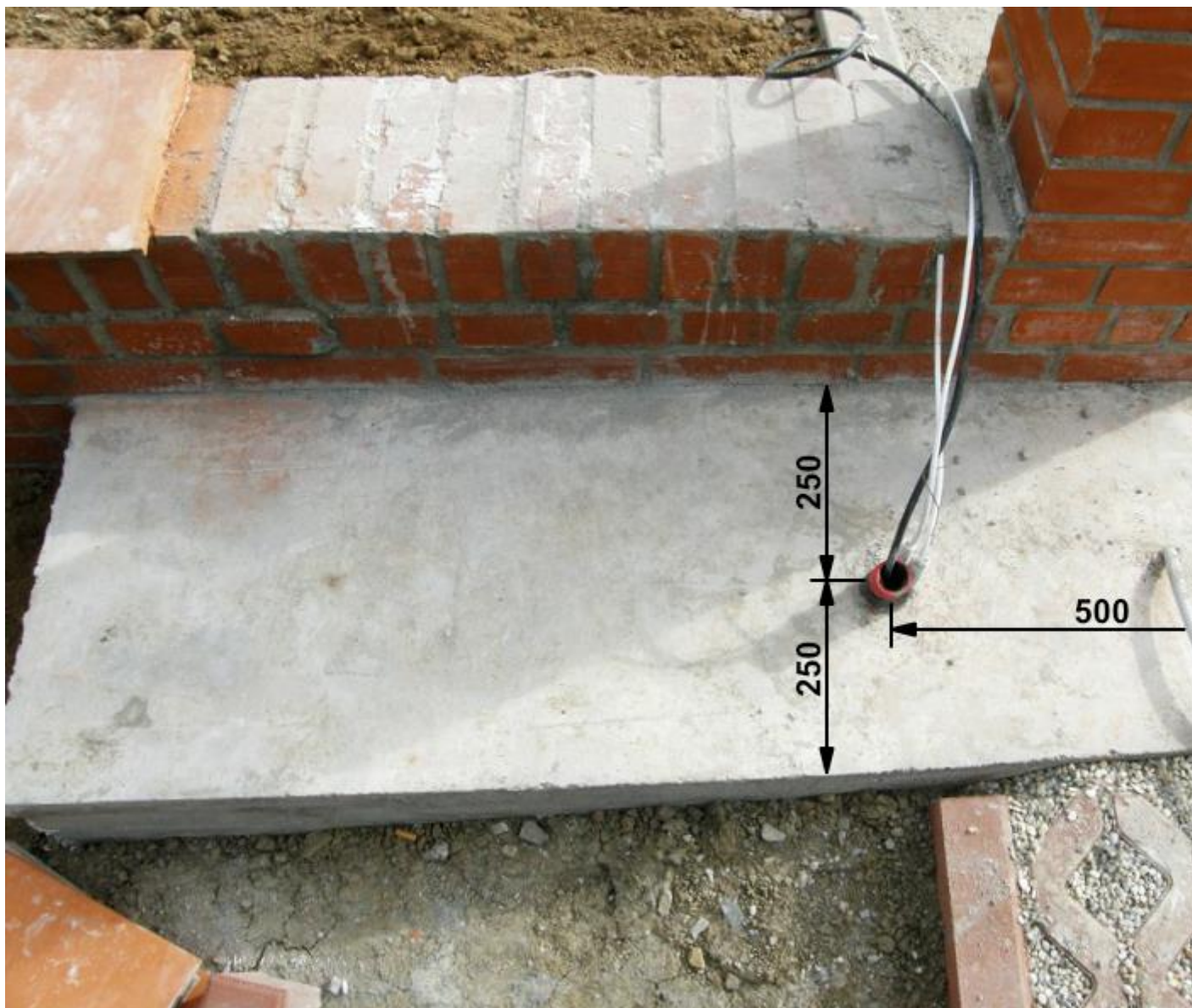
[kótování betonového otvoru]
